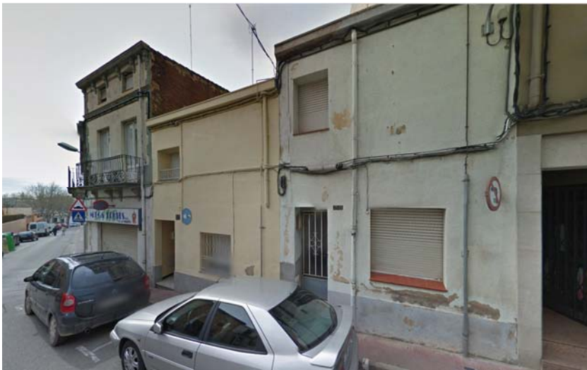
Carrer Raval (al nord del carrer Sant Martí)
