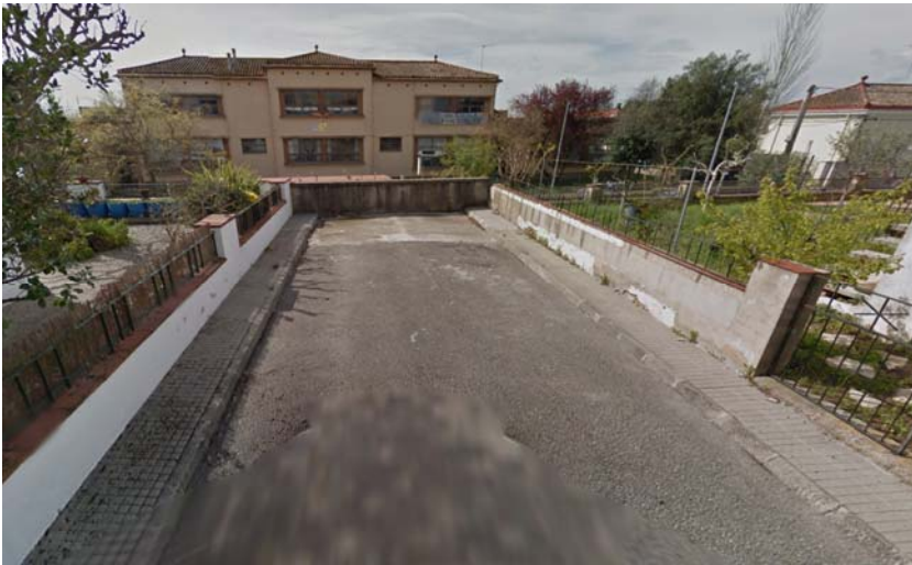
Carrer Sant Martí. Final sud
