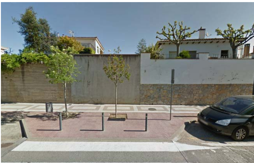
Mur al sud del Carrer Sant Martí vist des de la Rambla
