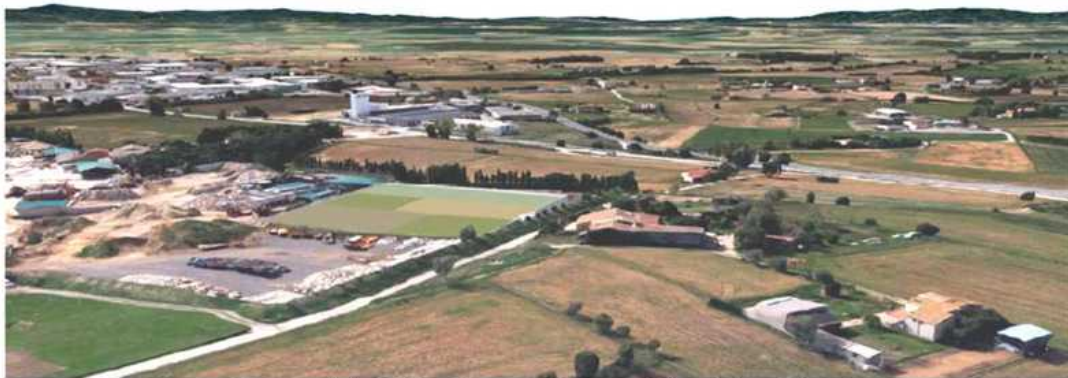
Comparatiu de la situació actual i futura amb visuals des del nord
