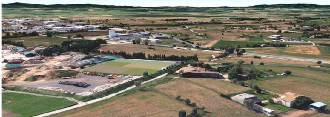
Vista aèria amb la nova nau que encapsula conté la màquina de triturar
