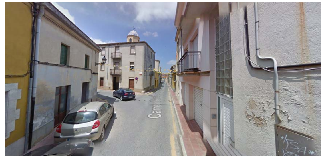
Figura 11. Imatge estat actual carrer d'Avall amb cruïlla amb carrer de Xavier Carbó.
