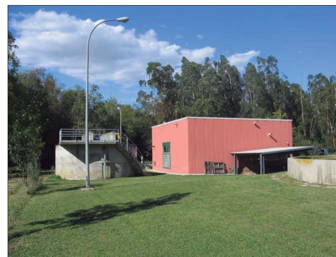
6 - espessidor i edifici de deshidratació
