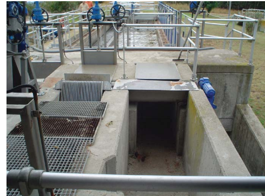
Fotografia 3 Desarenador- desgreixador
