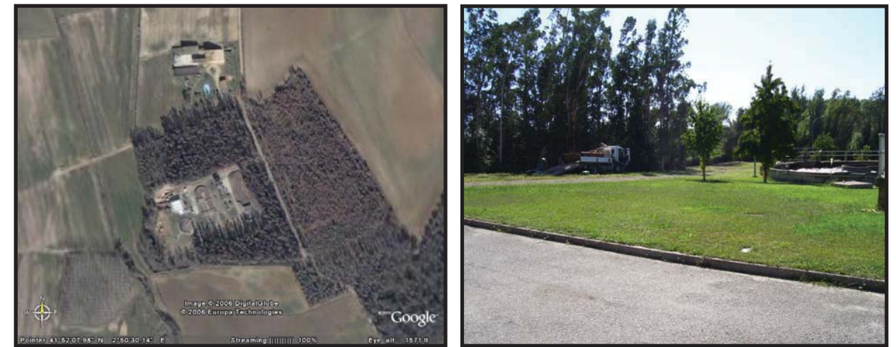
Detall de la depuradora i la zona on s'han emplaçat els punts de sondeig.
