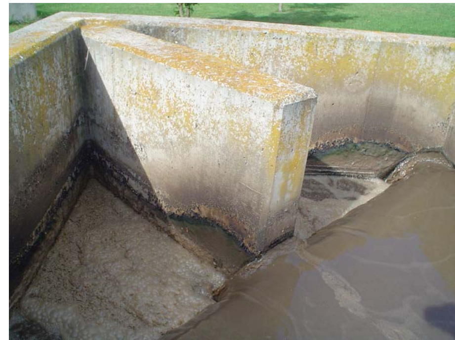
Fotografia 8. Arqueta de repartiment
