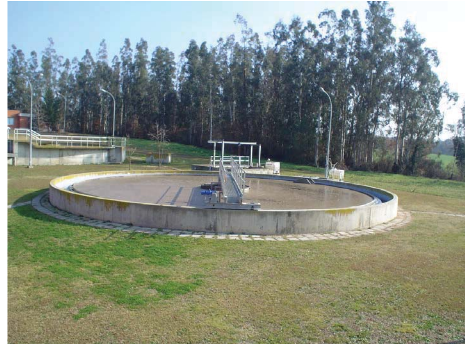
Fotografia 11. Decantador secundari
