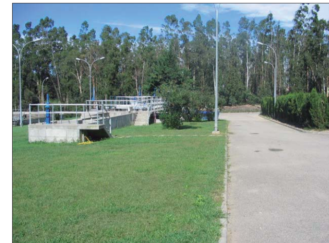
2 - accés a les oficines
