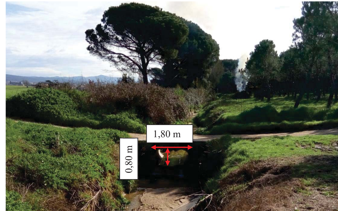
Figura 24. Obra de drenatge existent sobre la riera de Susvalls.
