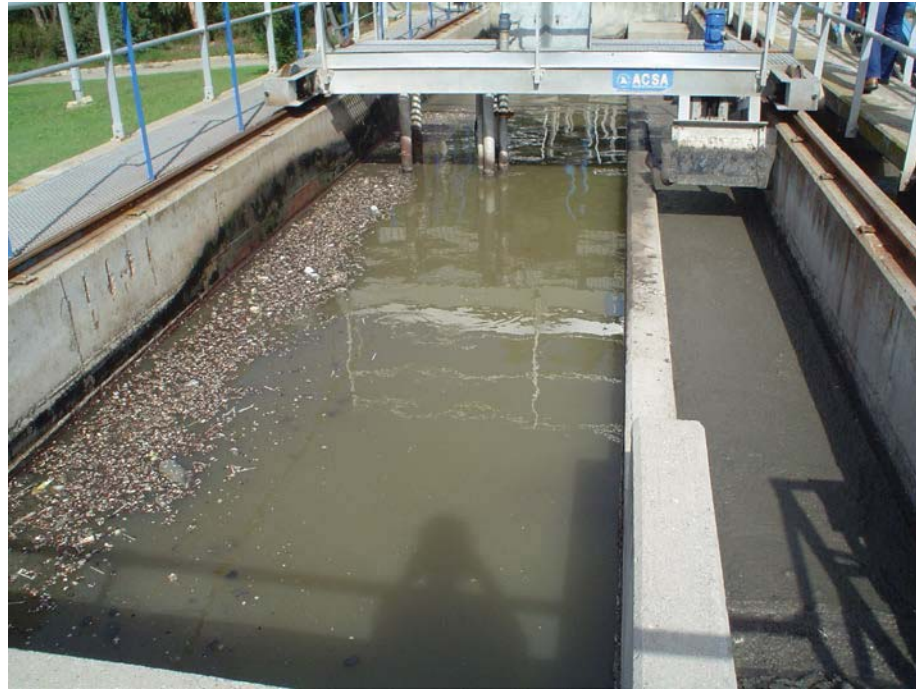
Fotografia 5 Detall desarenador - desengreixador
