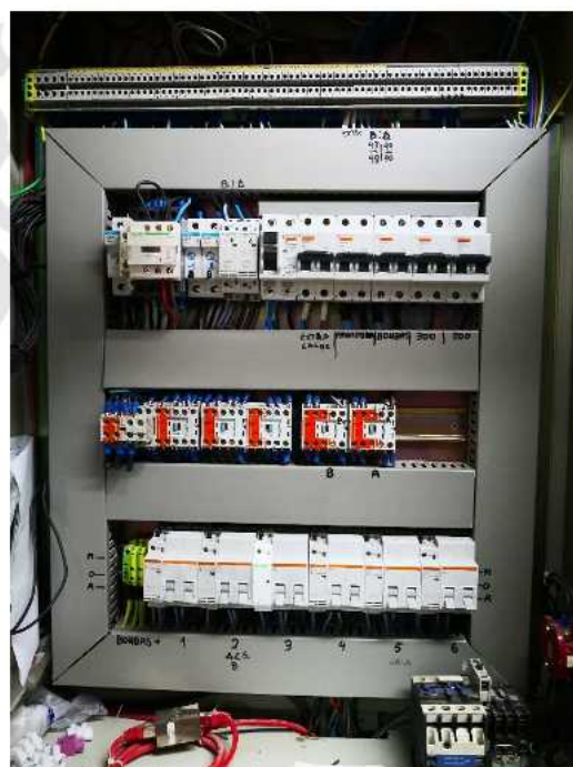
Fig. 6. Quadre de control de la sala de Calderes de l'Hospital Geriàtric
