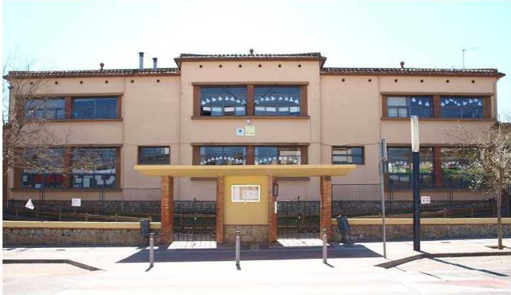
Fig. 7. Vista exterior del CEP Puig d'Arques
