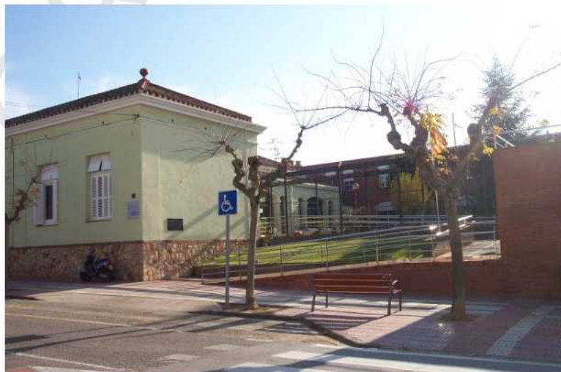
Fig. 2. Vista exterior de l'Hospital Geriàtric San Josep – Façana Nord (Rambla Onze de Setembre)
