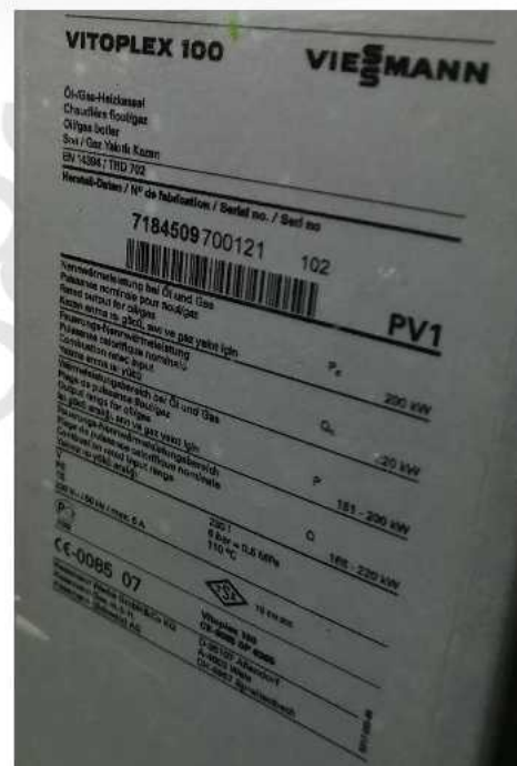
Fig. 5. Plaquas tècniques de les calderes de l'Hospital Geriàtric (150 i 200 kW)
