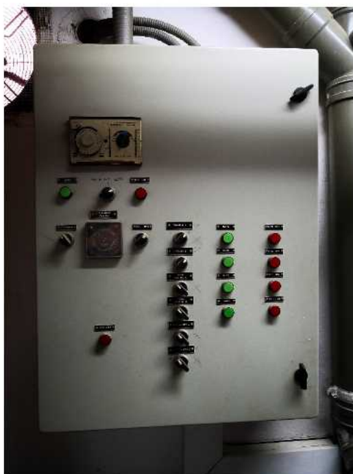
Fig. 6. Quadre de control de la sala de Calderes de l'Hospital Geriàtric
