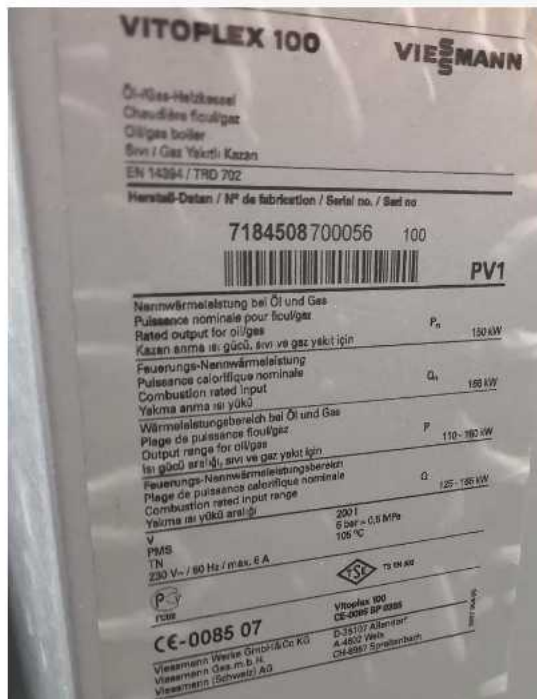
Fig. 5. Plaquas tècniques de les calderes de l'Hospital Geriàtric (150 i 200 kW)
