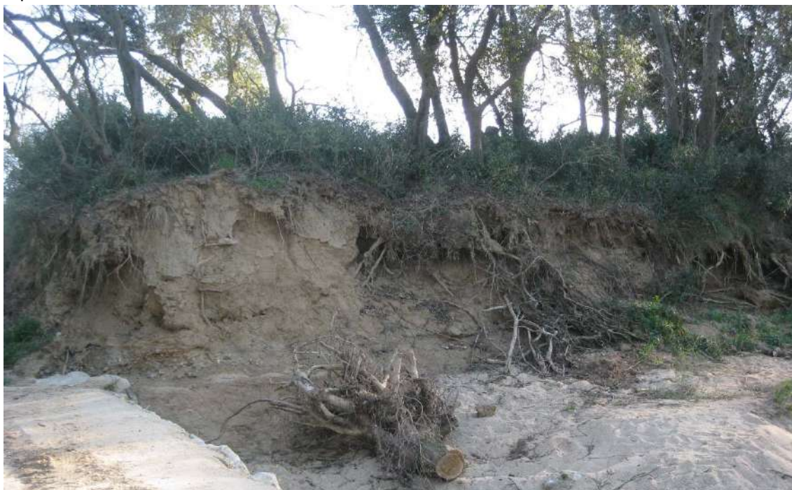
Marge de la riera de Verneda erosionat per les pujades de la riera
