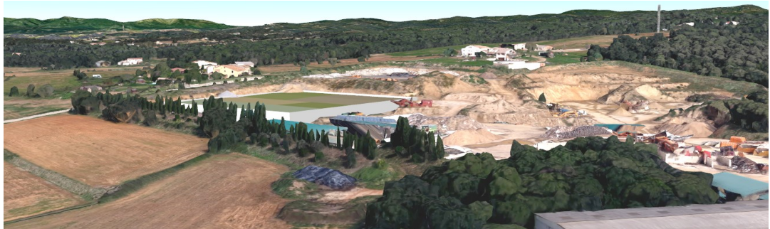
Vista aèria amb la nova nau que encapsula conté la màquina de triturar
