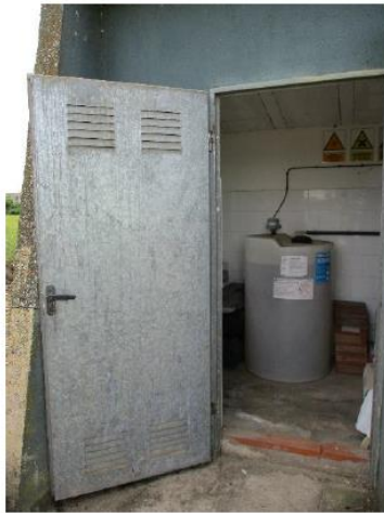
Figura 18. Sobreelevació Ter: emmagatzematge i dosificació d'hipoclorit sòdic
