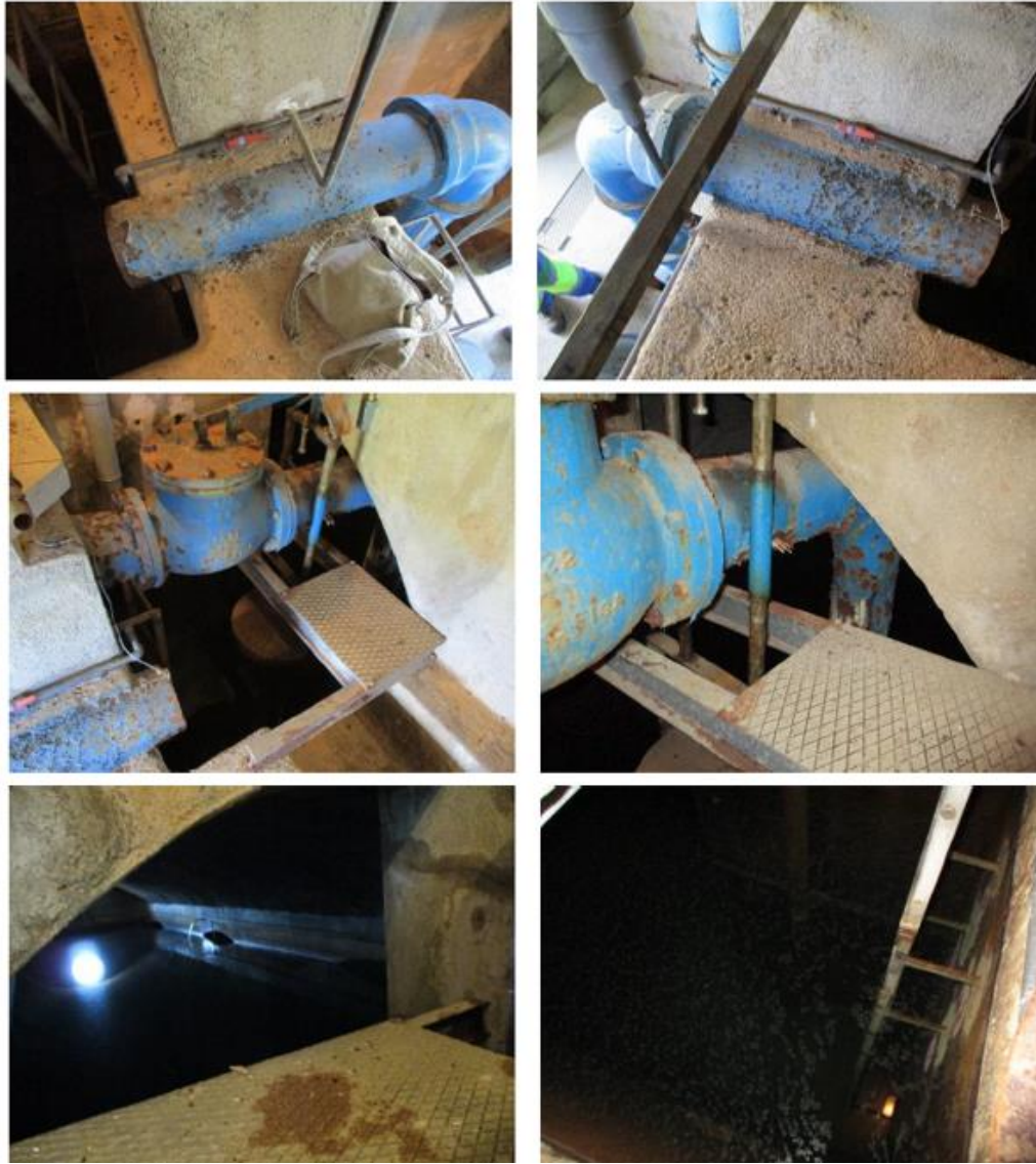
Figura 31. Dipòsit Vell: entrada d'aigua i accés als vasos
