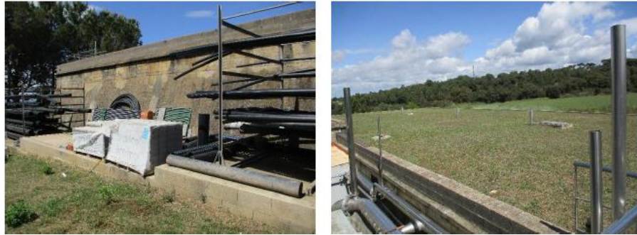
Figura 34. Dipòsit Nou: estat exterior, parcel·la i coberta
