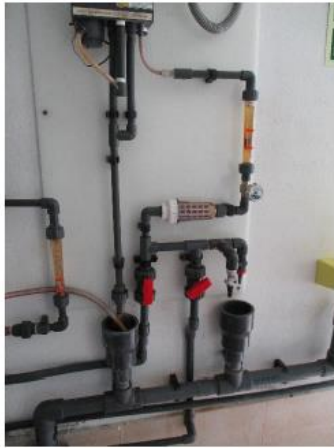
Figura 22. ETAP La Verneda: sala de dosificació de reactiu i d'analitzadors en línia
