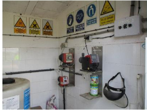
Figura 18. Sobreelevació Ter: emmagatzematge i dosificació d'hipoclorit sòdic
