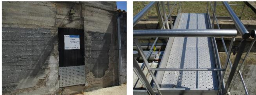
Figura 35. Dipòsit Nou: accés cambra de claus i accés coberta dipòsit
