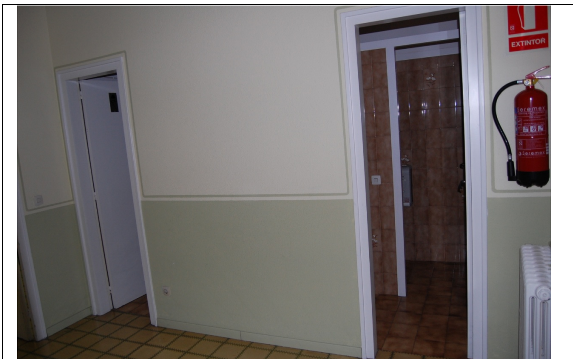
Foto 06 - Portes dels serveis de planta primera
