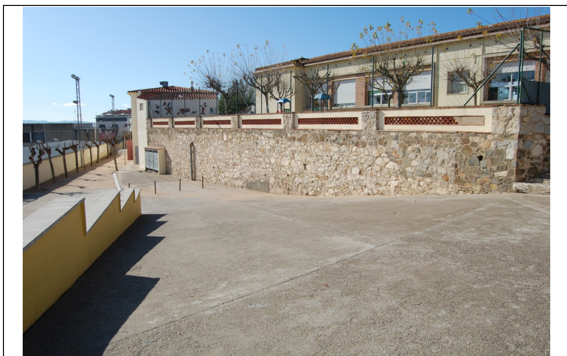
Foto 04 - Rampa superior d'accés a les grades
