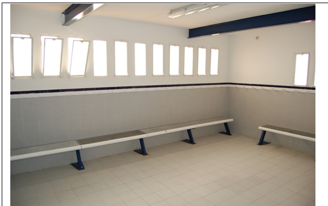
Foto 07 - Interior dels vestuaris existents
