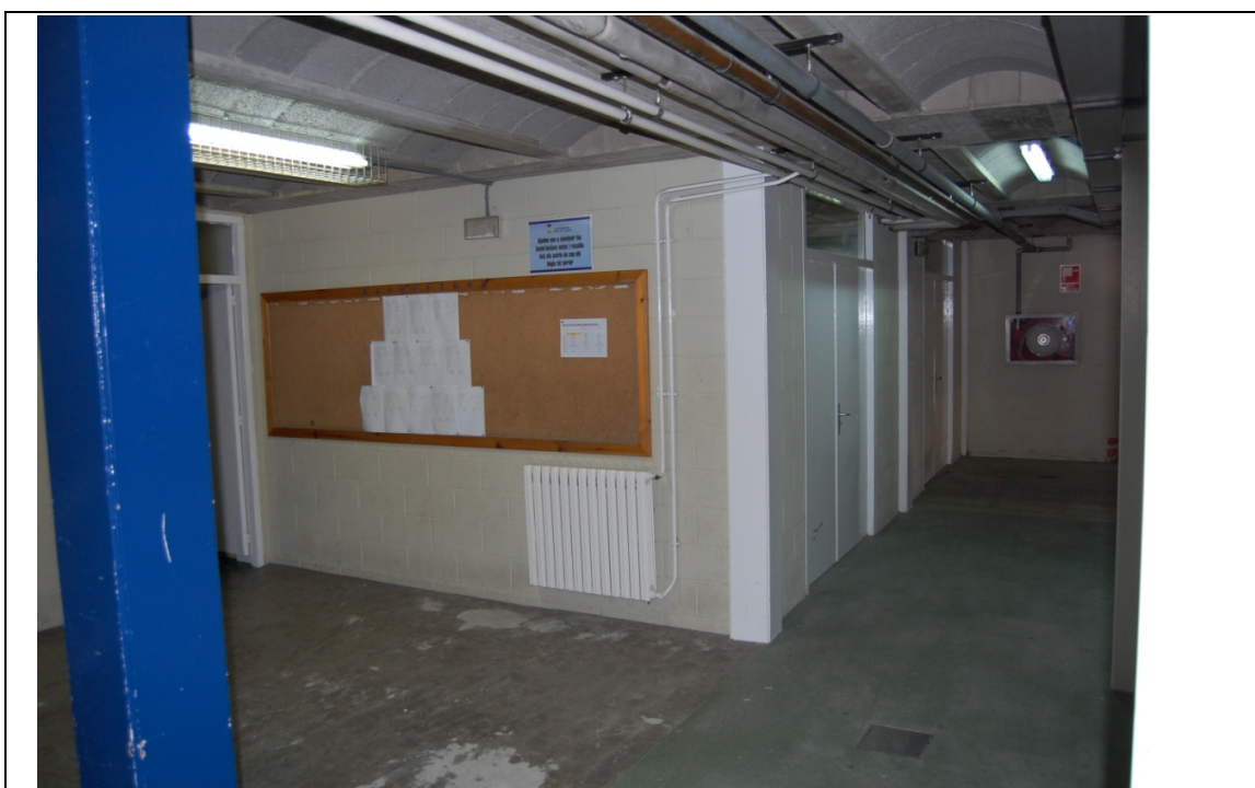
Foto 06 - Nivell inferior - Espai on es construirà el nou vestidor
