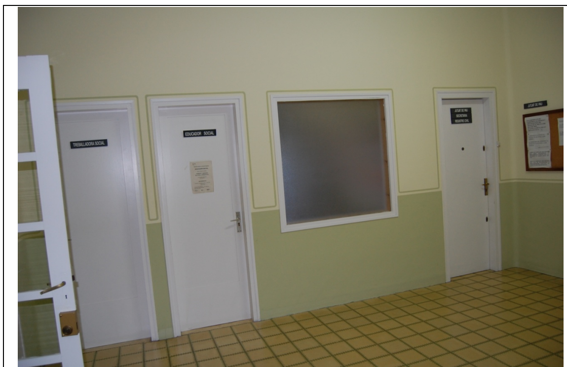
Foto 08 - Planta primera - Distribuïdor dels despatxos de serveis socials i el jutjat de pau
