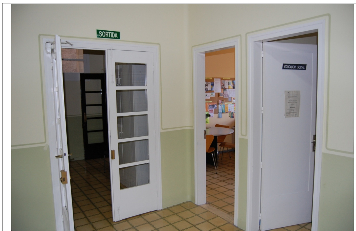
Foto 07 - Planta primera - Portes dels despatxos de serveis socials
