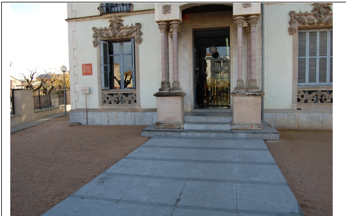
Foto 03 - Porta principal - Es veuen els tres graons d'accés a la porta
