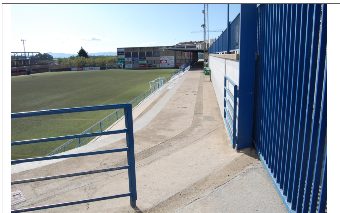
Foto 06 – Accés a grades
