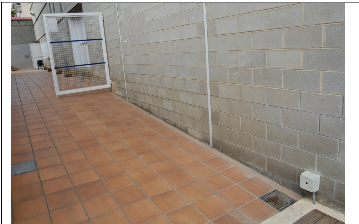
Foto 03 - Rampa d'arribada a l'interior del recinte
