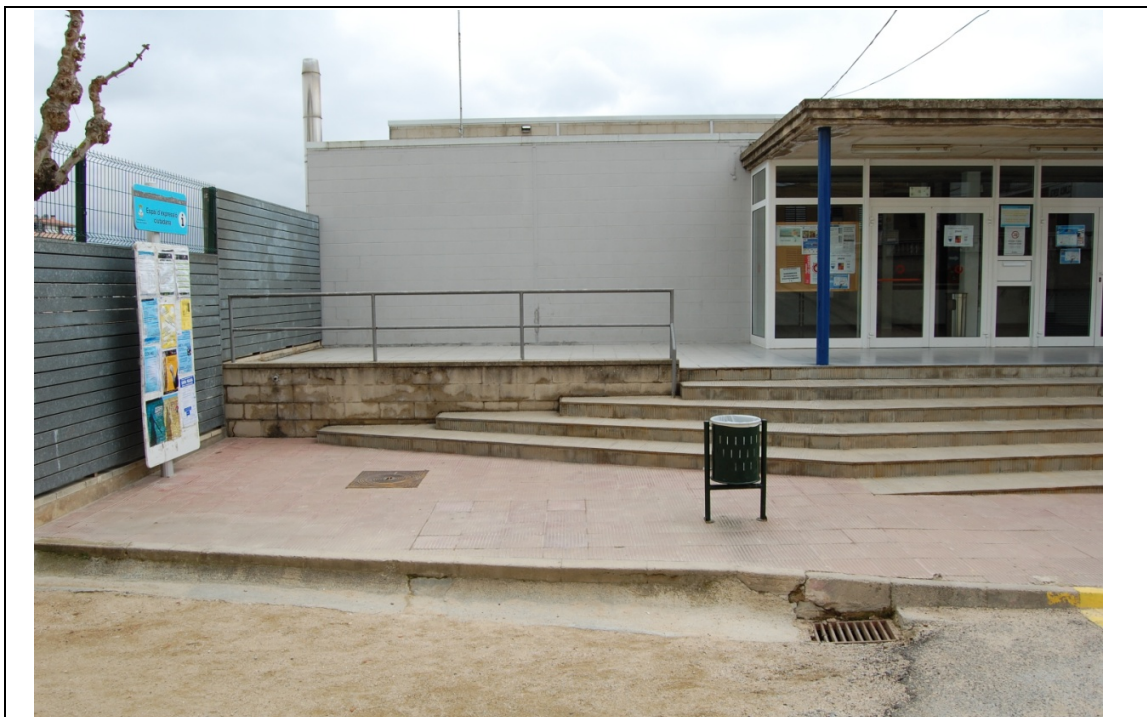
Foto 03 – Nivell superior – Espai on es construirà la rampa
