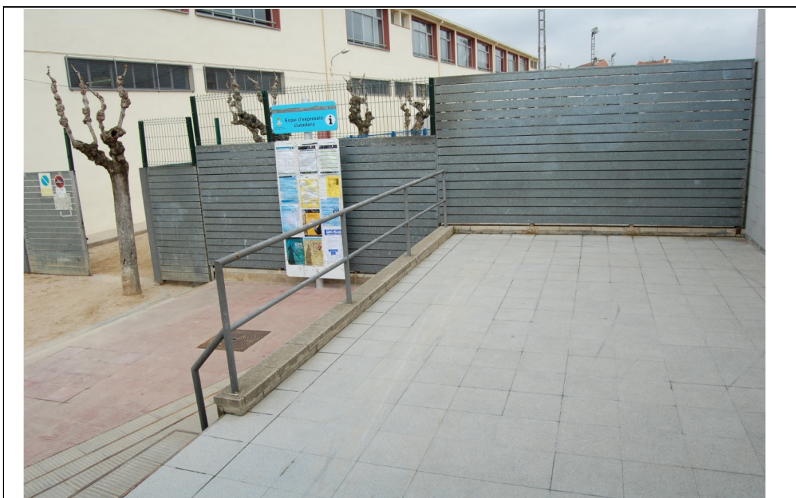
Foto 05 - Nivell superior - Espai on es construirà la rampa
