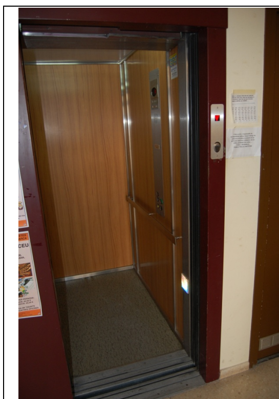
Foto 06 - Vista de l'ascensor
