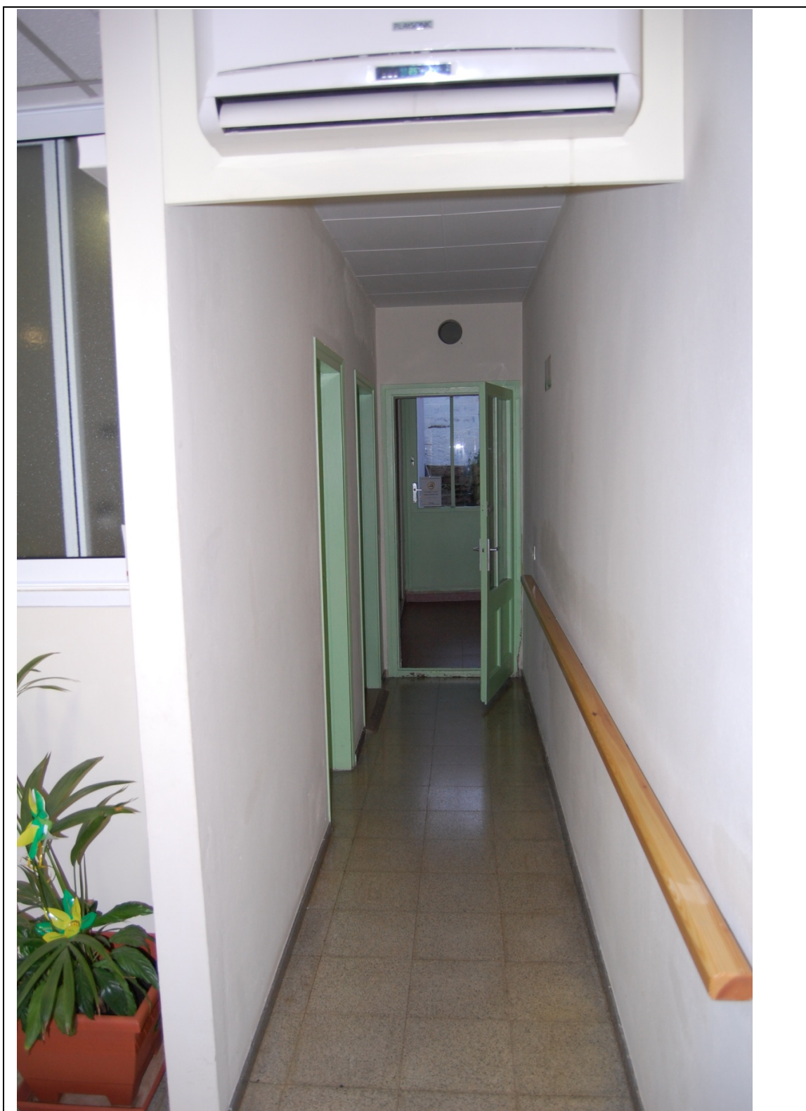
Foto 03 - Passadís interior - L'amplada de 110cm queda limitada per l'estructura
