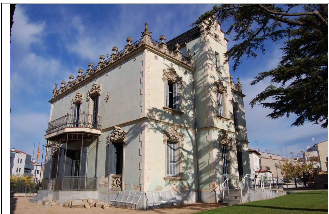
Foto 10 – Façana posterior – Es pot veure la rampa que no és accessible
