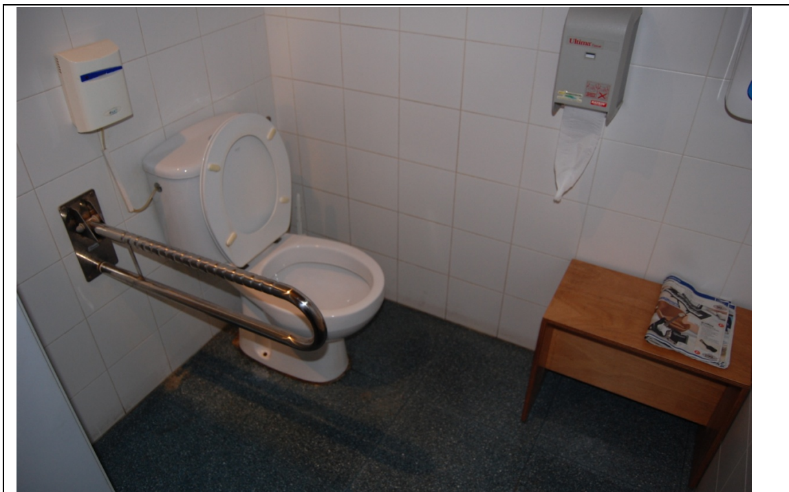
Foto 05 - WC en el servei - Falta la barra fixa de la paret i s'ha d'apartar l'armari del lateral
