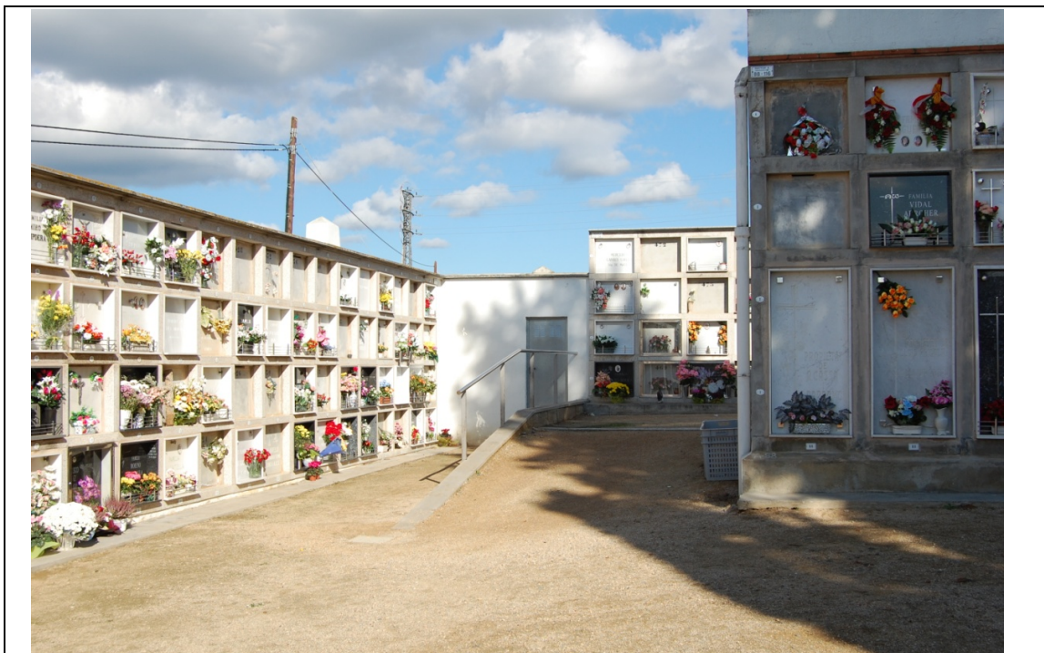
Foto 05 - Interior del recinte - Rampa
