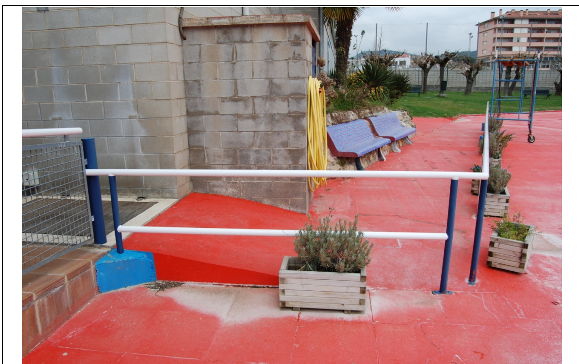
Foto 04 - Rampa d'arribada a l'interior del recinte
