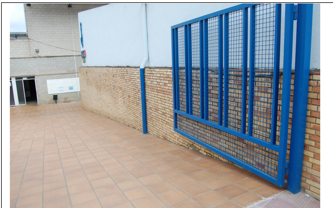
Foto 02 - Rampa de l'accés principal
