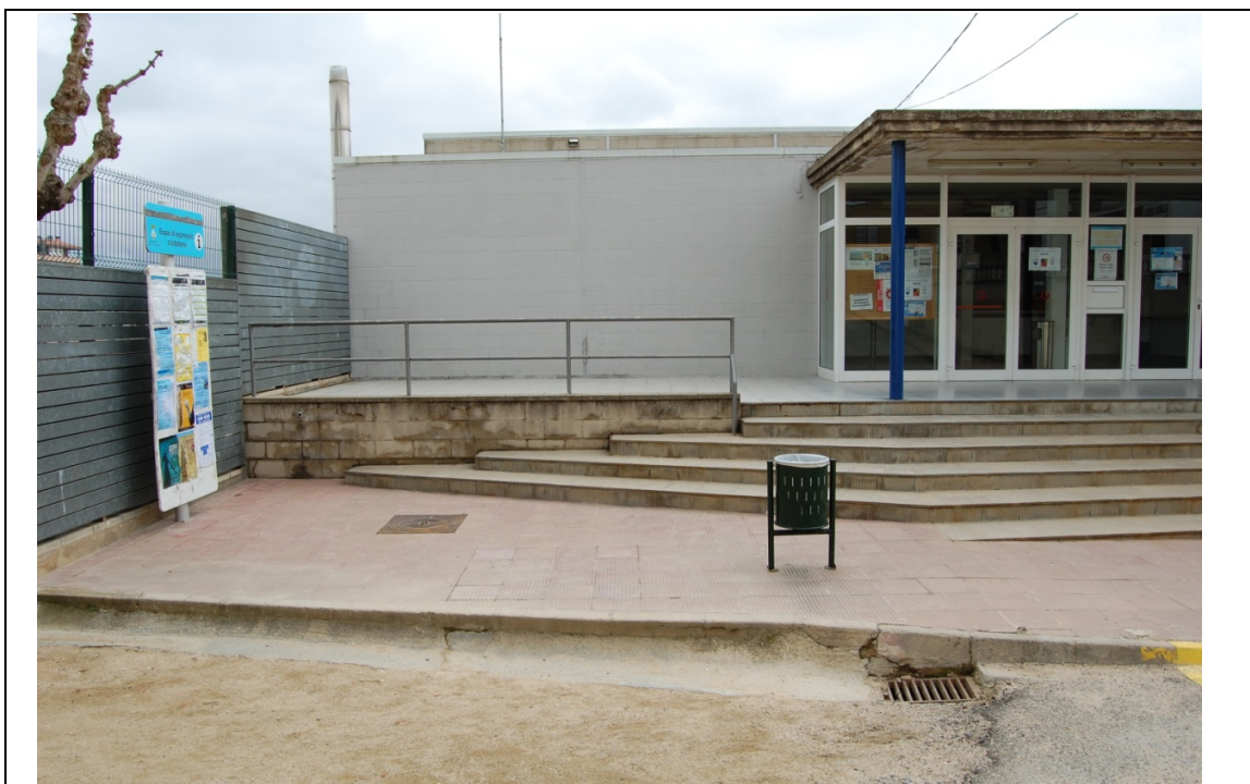
Foto 04 – Nivell superior – Espai on es construirà la rampa
