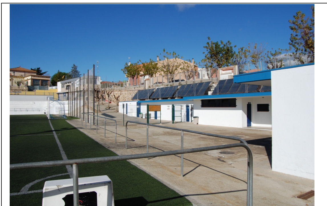
Foto 10 – Vista general edifici de vestuaris – Actualment anul·lats
