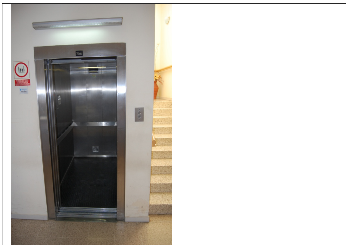
Foto 06 - Vista de l'ascensor
