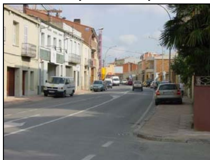
Imatge 3.12: carrer de paviment únic amb separació de pilons
