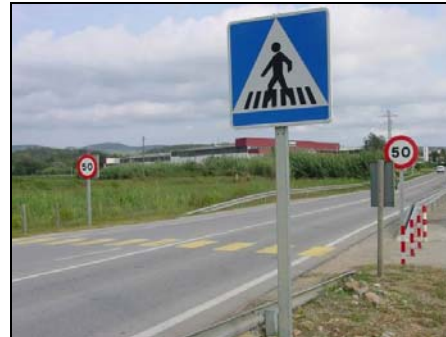
Imatge 3.16: intersecció a nivell del carril bici amb la C-65
