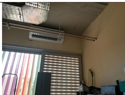
Punt entrada a l'edifici
