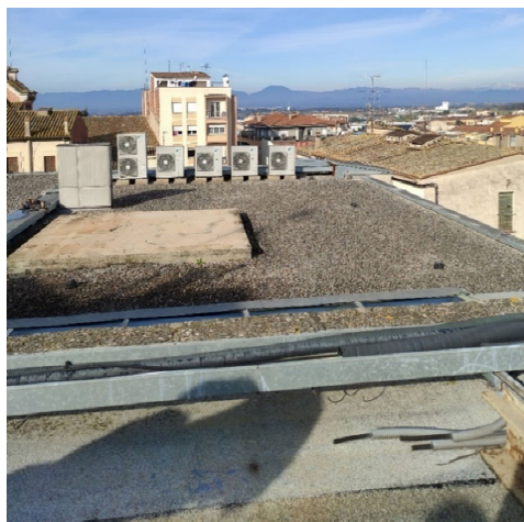
Figura 5. Vista de la coberta actual.
