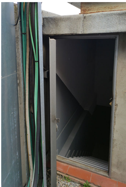
Figura 6. Escala d'accés a coberta.
